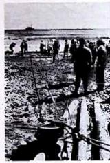
Na een reis van duizenden kilometers over de zeebodem wordt de onderzeeske kabel aan land getrokken.
